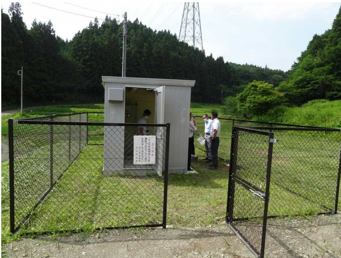
権現地区取水施設設置工事
