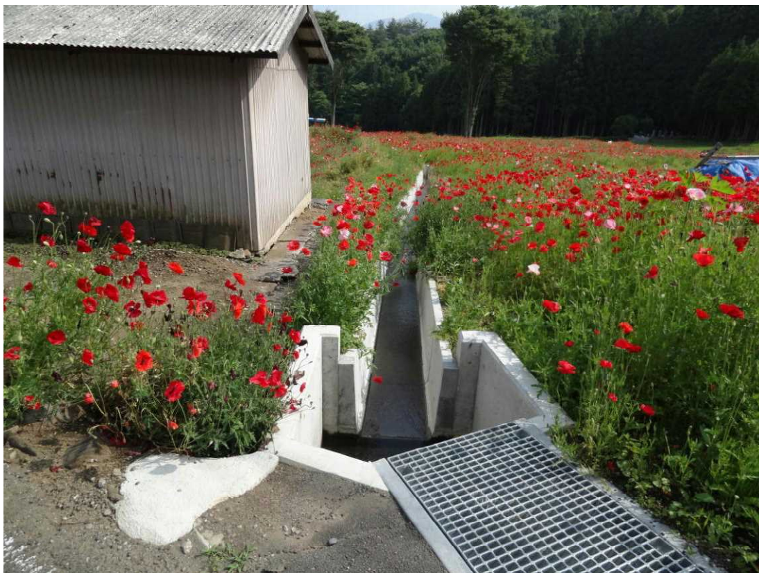
五領地区水路整備工事
