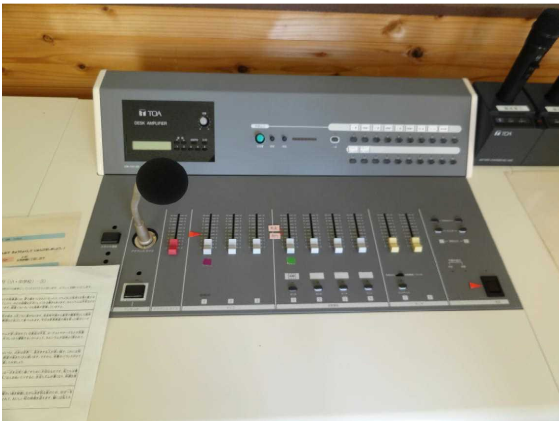
高山小学校放送設備更新工事
