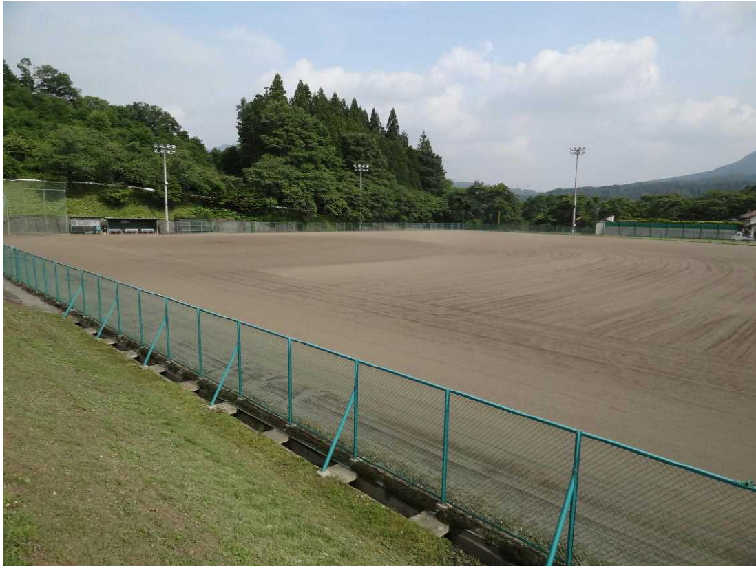
高山村スポーツ広場（野球場）改修工事
