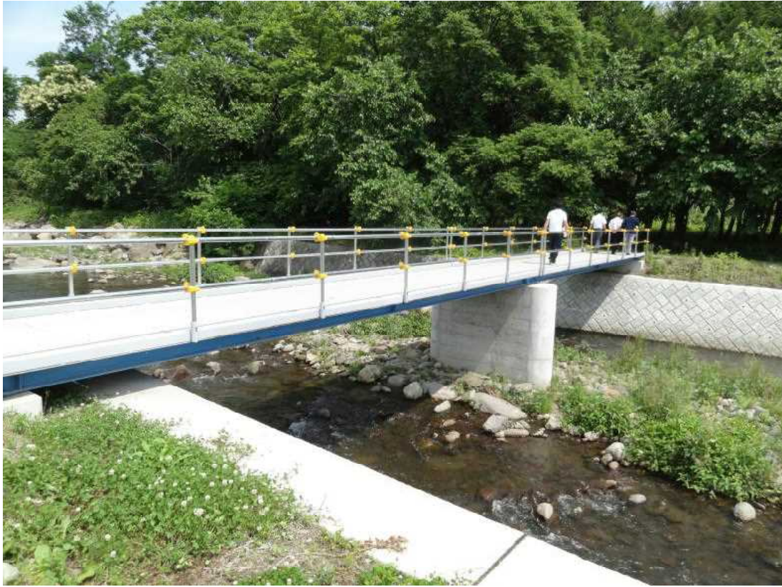
依火橋建設工事
