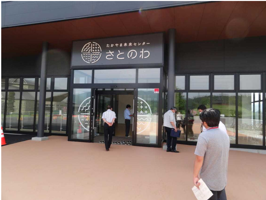
道の駅中山盆地高山観光交流館新築工事
